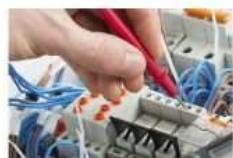
ADDETTO IMPIANTI ELETTRICI E CIVILI
