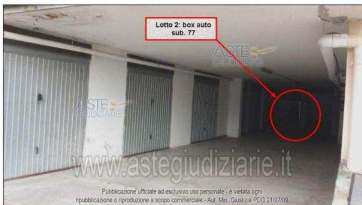
Foto 21 – Area condominiale di manovra per l'ingresso ai box auto
