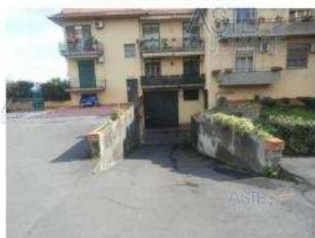
Foto 62: rampa di accesso immobili 4-5
