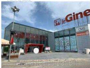
Foto 2 - Vista dell'ingresso del complesso immobiliare denominato "CENTRO COMMERCIALE LE GINESTRE"
