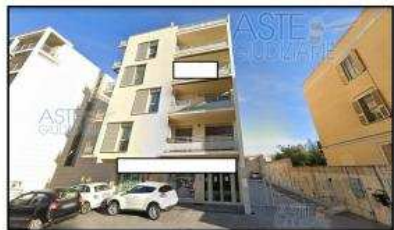
Foto 2: Prospetto principale del fabbricato, lungo Viale Della Vittoria
