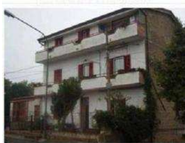
Foto 2: Vista esterna - Foglio 9, P.la 311, sub 1 - 4 - 5 - 6
