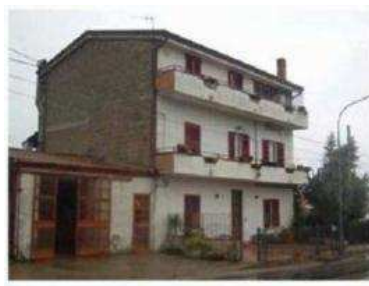
Foto 1: Vista esterna - Foglio 9, P.la 311, sub 1 - 4 - 5 - 6
