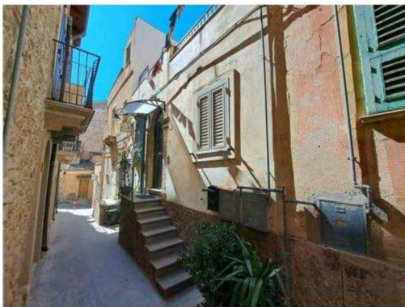
Foto 1 - Prospetto del fabbricato su via Nizza
