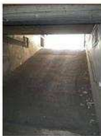
Foto 2 - Piano interrato: box
